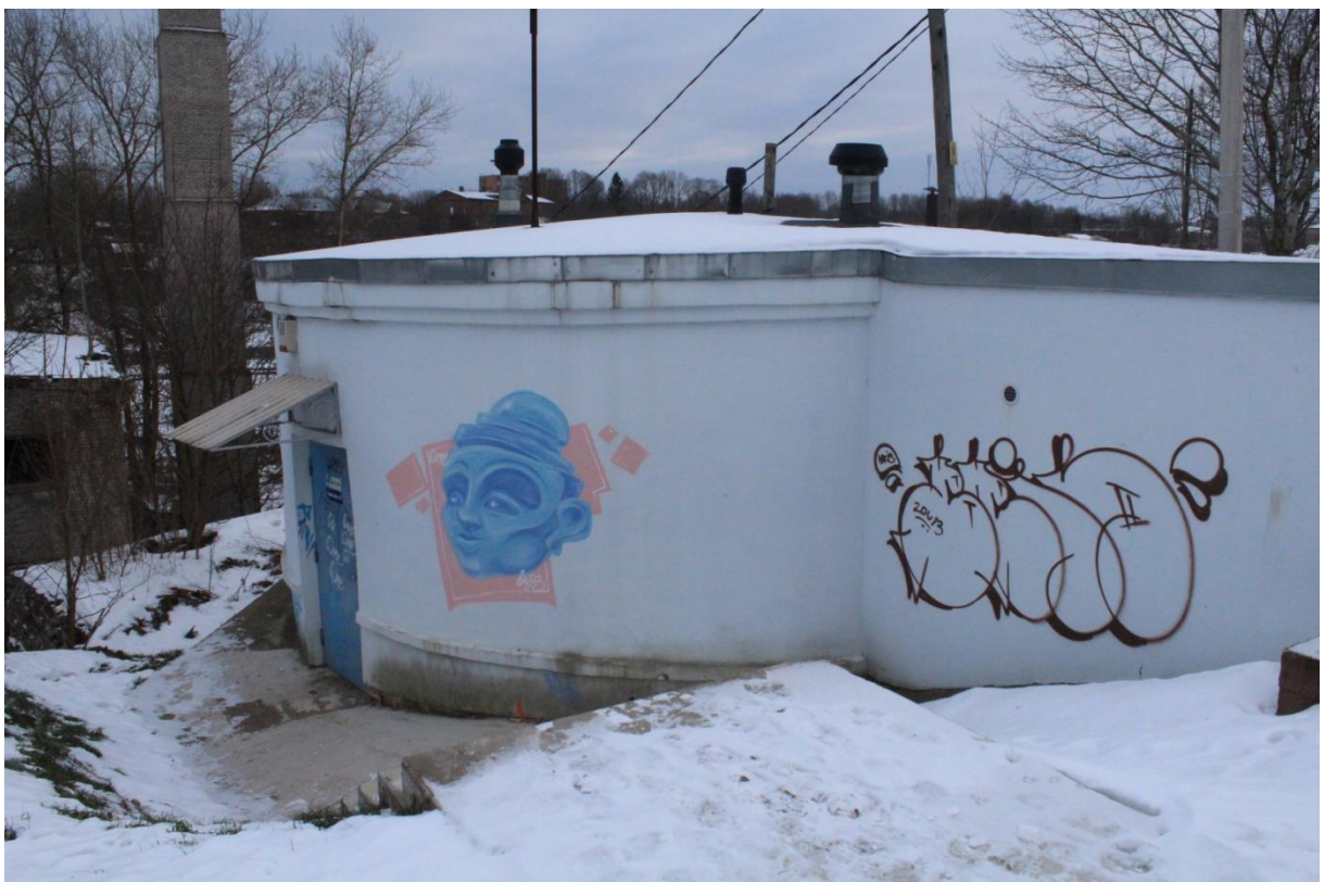
Foto 6.2 Kanalisatsiooni pumpla nr 5
