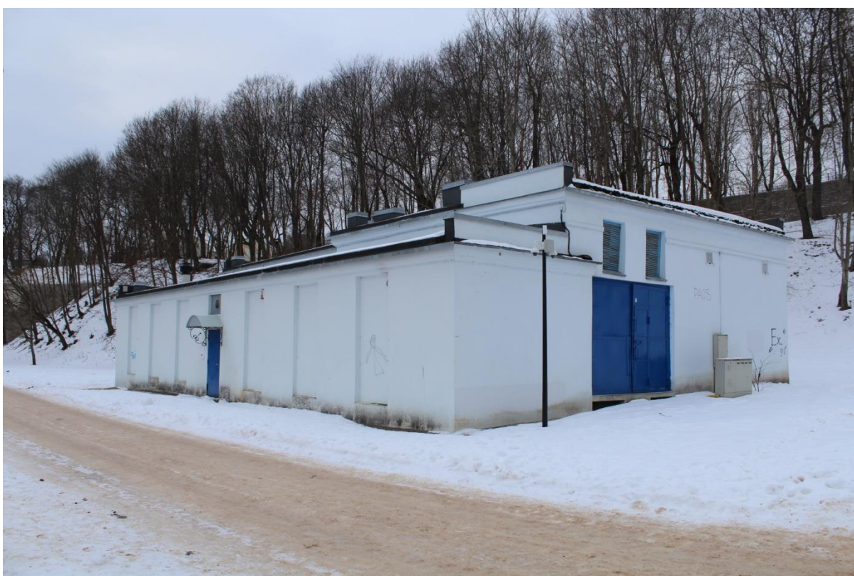
Foto 6.4 Kanalisatsiooni pumpla nr 4
