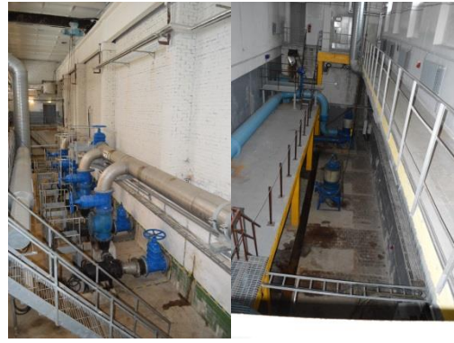
Vaade peapumplate pumpade ruumidele
