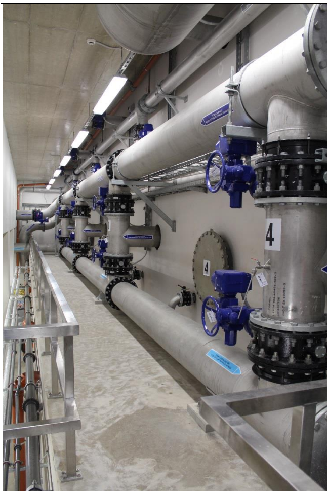
Foto 5.4 Kahekihilised filtrid ja juhtarmatuur
