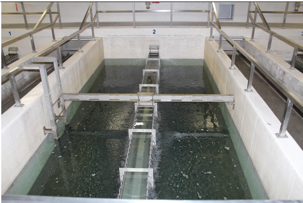
Foto 5.6 Vee töötlusjaama aktiivsöefiltrid.
