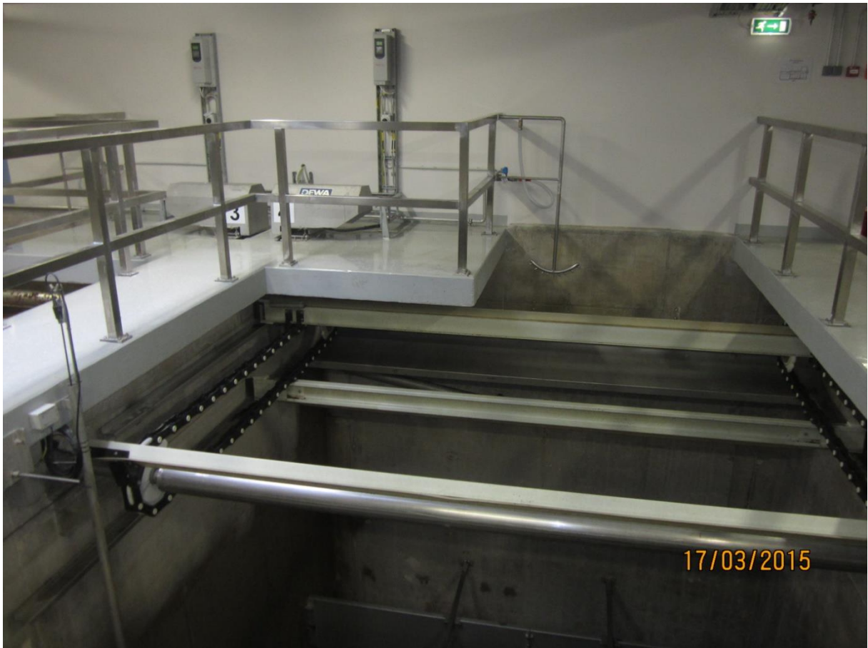
Foto 5.3 Narva linna veetöötusjaama SPIDFLOW® flotatsioonibasseinid
