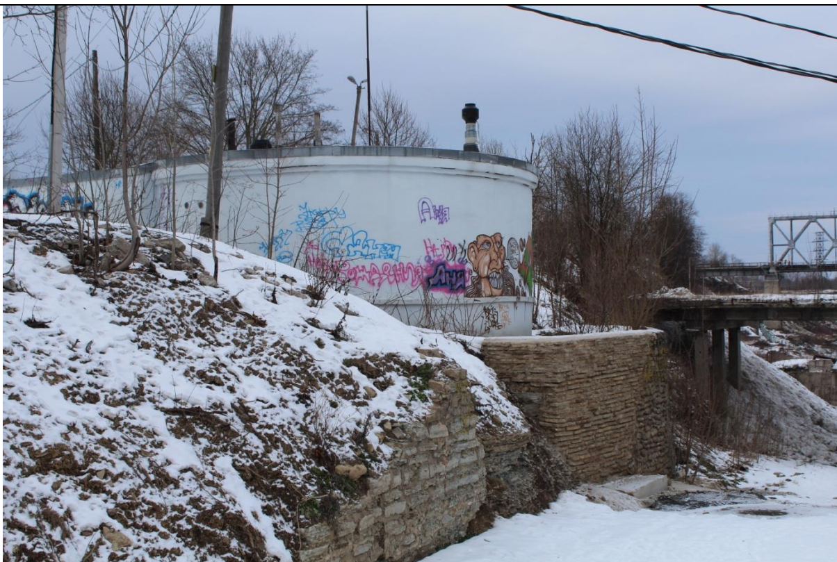
Foto 6.3 Kanalisatsiooni pumpla nr 5
