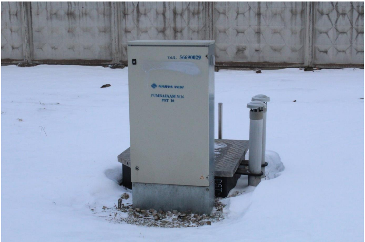
Foto 6.1 Kanalisatsiooni kompaktpumpla (10 tk)
