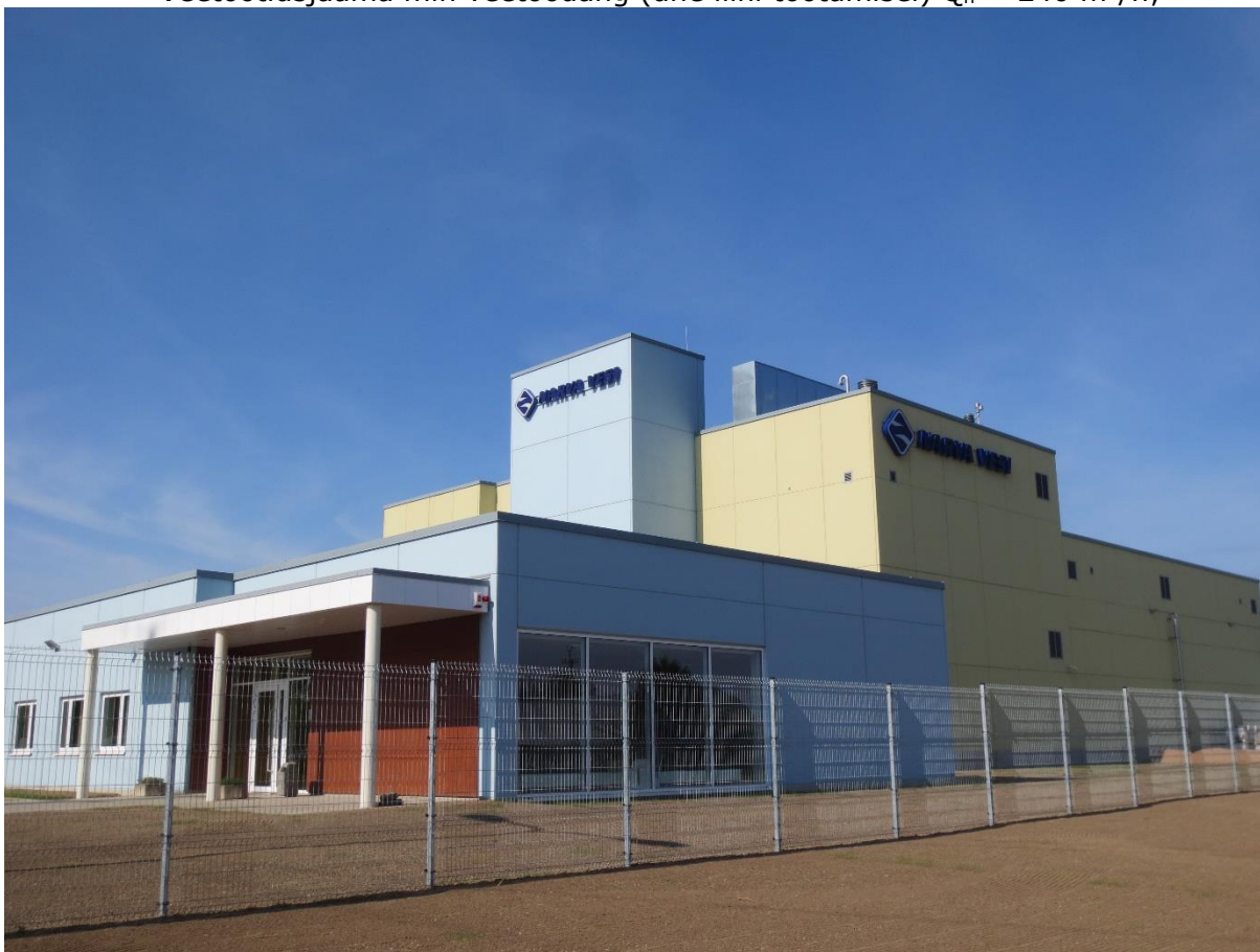
Foto 5.2 Uue veetöötlusjaama välisvaade (2015 suvi)
